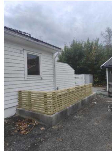
Rekkverk montert etter befaring.
